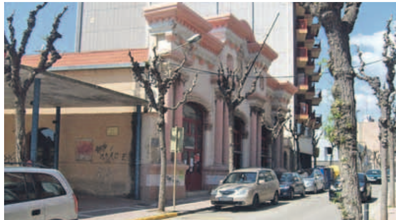
Primers acords per a la rehabilitació del teatre de Els Salistes. O.S.
